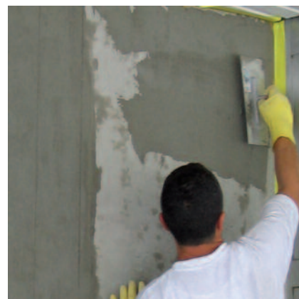
PCI Barrafill L bij cosmetische reparatie aan betonnen constructies.
